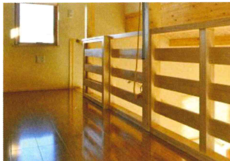
フローリングのコーティング
