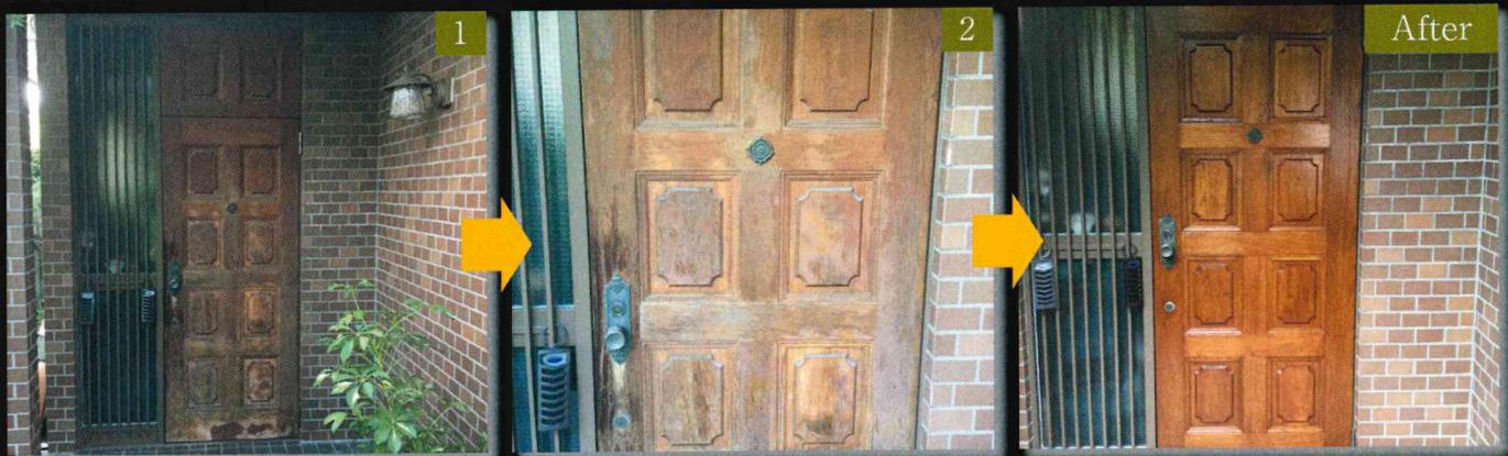
木製のドアが長い年月の風や雨により、塗装が劣化してカビやシミができています。ドア全体の塗装を剥がしてカビやシミを抜き、着色塗装をしてコーティングをすれば、元のようなきれいな状態へ戻ります。
