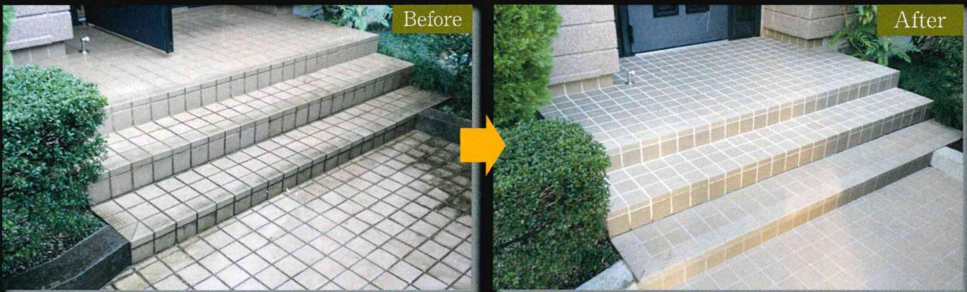
雨水や散水等により、目地から出てきたカルシウムに汚れが引つかかった状態です。電解水等の安全な洗剤等により、洗浄を行い、シミやカルシウムを取り除き全体をコーティング。防水性能が付与された床になっています。
