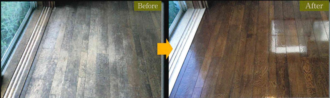
外部の光や水分等、長年の使用によりフローリングの塗装の膜が劣化してしまい、下地の板が出て来てシミだらけになっています。塗装の膜を全体の半分取り除き、カビ・シミを抜いて着色後、コーティングで仕上げています。
