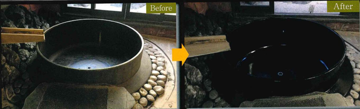
毎日使用する風呂でも、空気と触れる事によりサビが発生。鉄部分のサビを塗膜に変換させる加工を行い、トップ部分にコーティングをして年に1回のメンテナンスを行っています。
