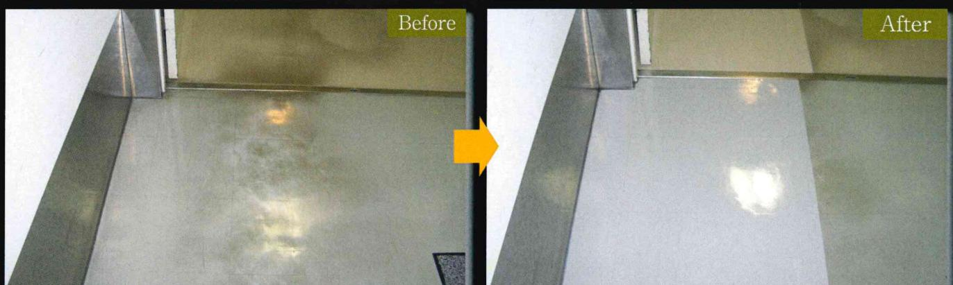
通用口の部分にワックスノメンテナンスが行われていて、汚れをワックスの奥に吸収して汚い状態でした。右はワックスを除去した状態に、汚れないコーティング、ノンスリップの床をサンプル施工しています。
