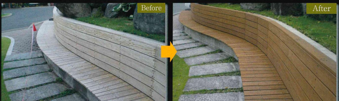
年月が経った為塗装の膜が弱くなって、カビやシミが出来ている状態です。一度カビやシミを除去して着色を行い、塗装の上に防水のコーティングをかけて仕上げています。最初の状態にかえっています。
