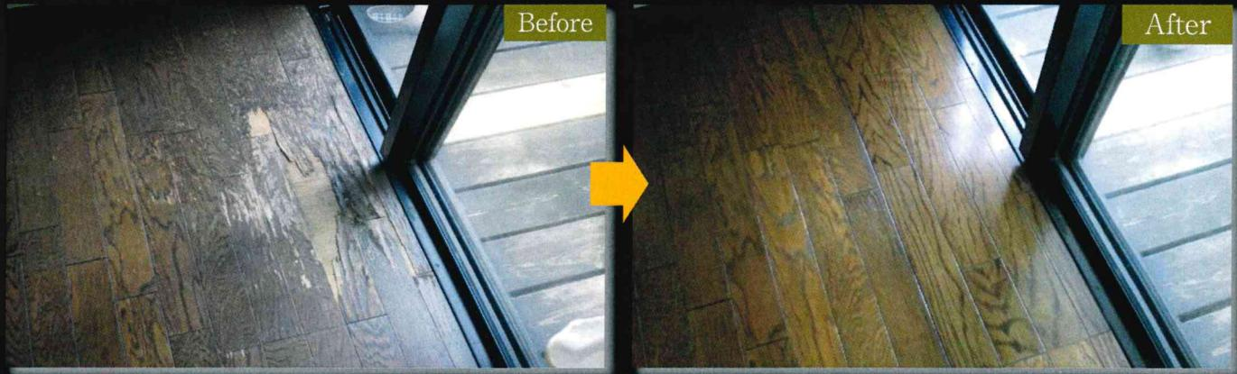
日光や外部からの水の進入があり、天板が傷んだままにしていた事からめぐれて、うすい天板(1mm~2mm)が無くなっています。この板(1800mm×300mm)のフロアーの上部5mmのみをけずり、着色してベースコート+トップコートで再発防止を行なっています。
