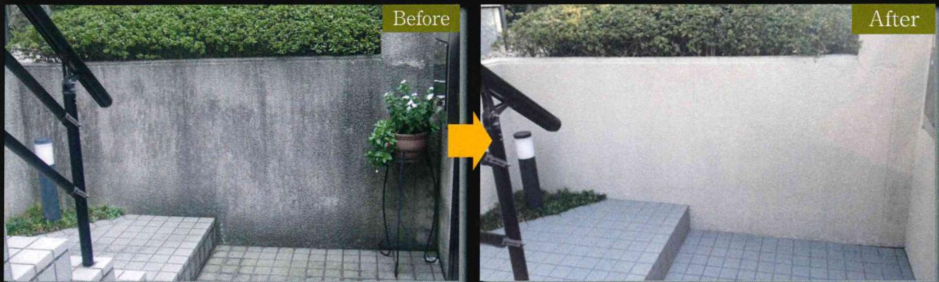
玄関も壁とタイル床がきれいになれば、全体のイメージも変わって見えます。シミやカビを抜き防水性能の高いコーティングを行っています。
