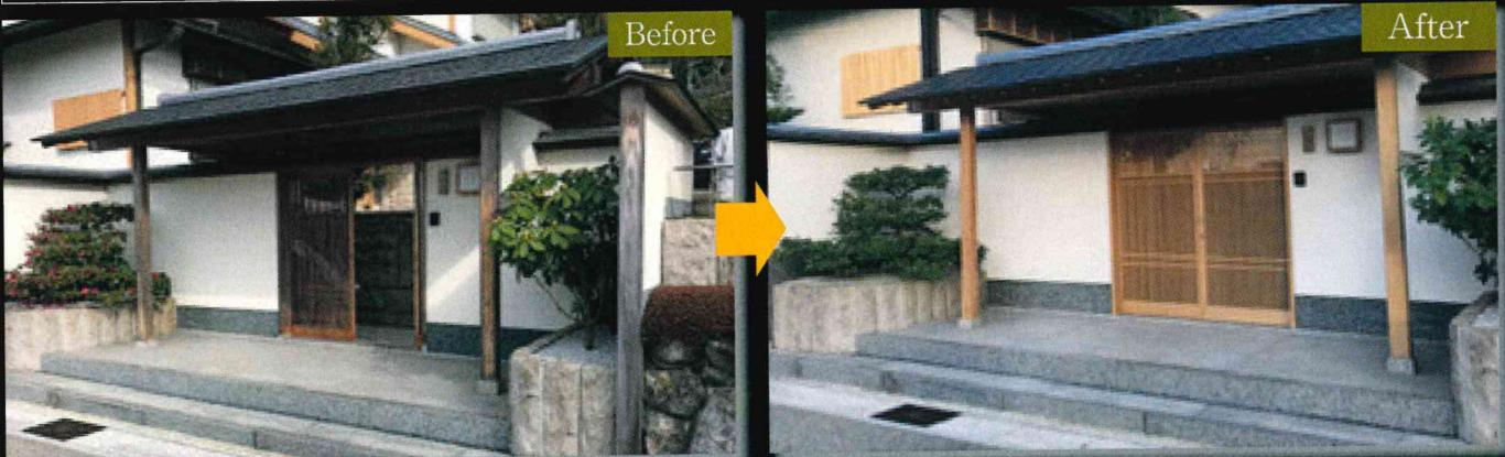
立派な玄関が、時の経過と共に薄暗い状況になって行きます。全体をアク抜き、シミ抜きをおこなう事により、素晴らしい玄関に戻りました。最後は白木専用のコーティングを行なって施工完了です。
