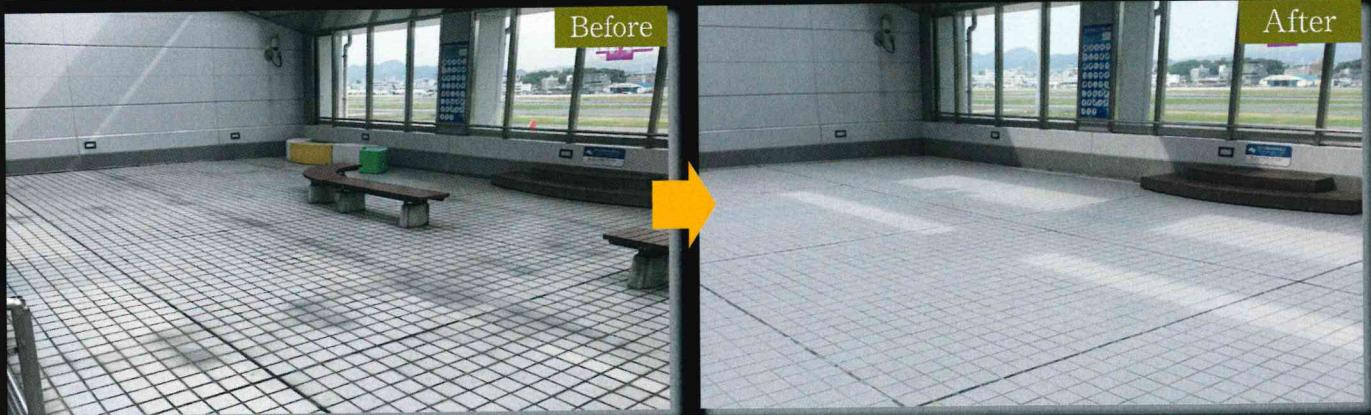
航空機の燃料が、長い年月により汚れと一緒に積み重なった状態で、汚れが固着して困った状態でした。鉱物油の汚れなので、洗浄して油分を除去し、全体にコーティングをしました。メンテナンスしやすい床に仕上がっています。
