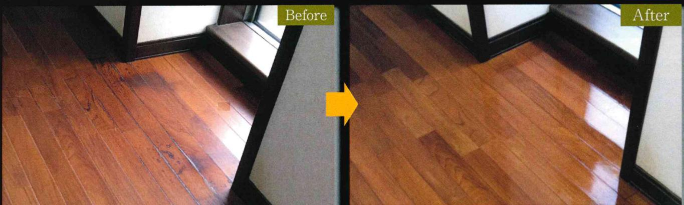
屋内の花ばち等により、部分的にカビやシミが発生しています。その部分だけ塗装膜をはがして、カビ・シミを除去して周りの色と合わせて着色仕上げ、その後塗膜の上にコーティングを塗布。
