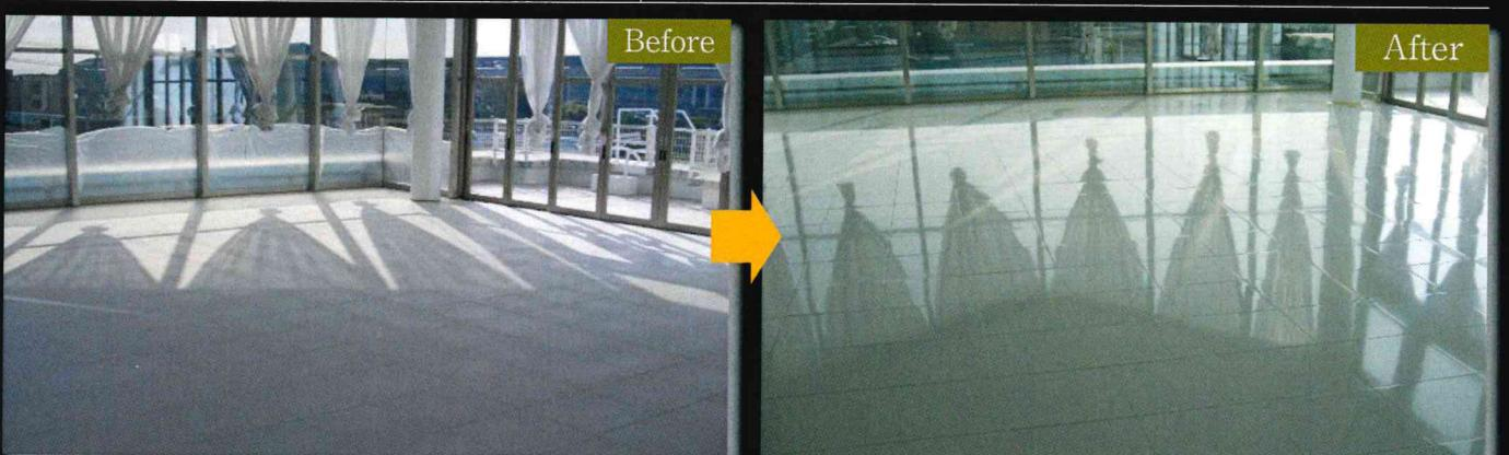
大理石を酸性の洗剤で洗浄して、ツヤボケした状態となっている現場からの相談でした。全体に洗浄から下地を作り上げ、研磨を3工程行い、ガラスコートで仕上げています。
