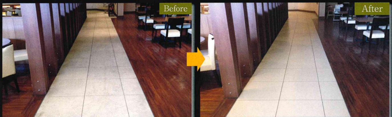
共有の食事をする場所の為、下に食品が落ちて汚れが全体にありました。全面のシミを取り除いた後、コーティングでノンスリップの汚れない床を完成させて、メンテナンス性の良いものとなっています。
