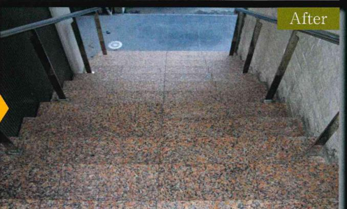
焼き肉店の階段が、内部の厨房からの油で、汚れてしまっている状態です。全体に洗剤や脱脂処理を行い、シミや汚れを取り除いて塗膜性のガラスコーティングでノンスリップ、汚れ防止、メンテナンスが簡単な床に仕上げています。
