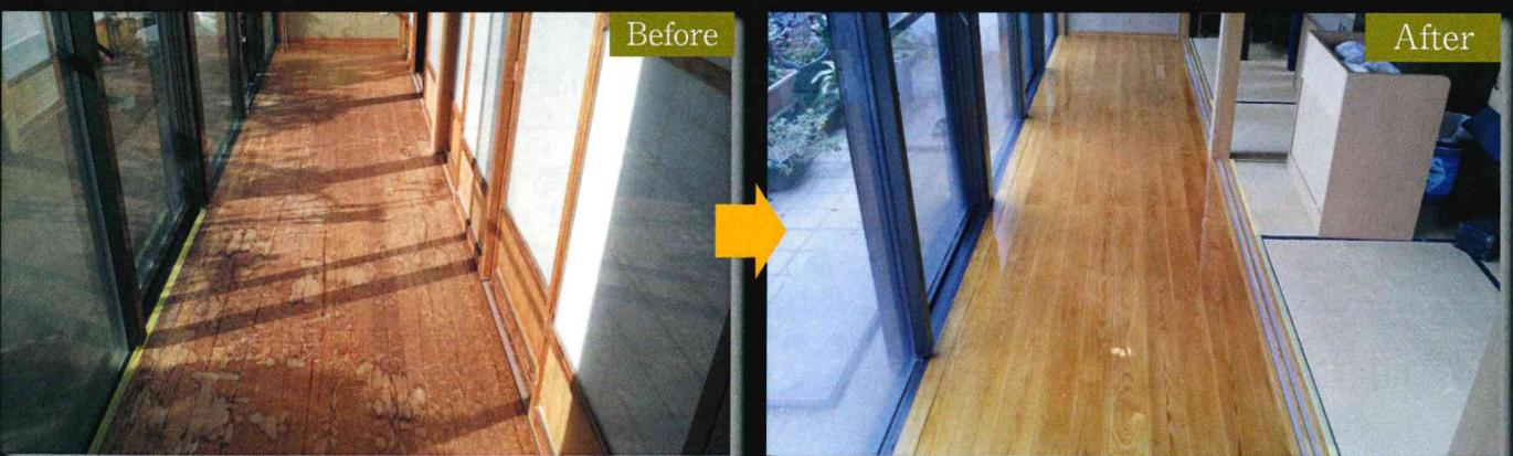
長年の使用で日焼け、洗たく物干しの為シミが発生しています。全面的に塗装を除去し、シミ・カビを抜き、傷を補修後、防水性のコーティングで床を完成させています。これからはシミが付きにくい床になっています。
