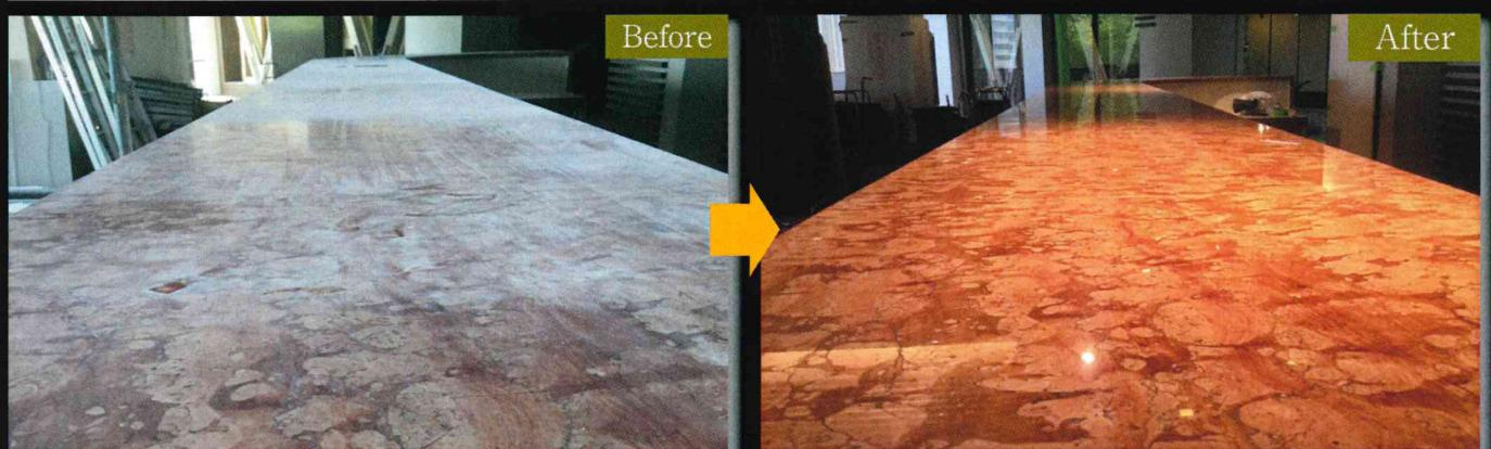
全面改裝の時にロビーカウンターの取り換えを検討されているとき、レストアの提案をさせて頂きました。古いカウンターを4工程の研磨・磨きで修復して、仕上げにガラスのコーティングを行いました。
