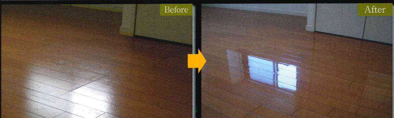
長い年月での使用により、床全面にキズやくぼみ、へこみができています。ワックスの仕上げではこのような状態になりますから、床全体をレストア工法でくぼみ、へこみを修復してからUV系のコーティング施工しています。
