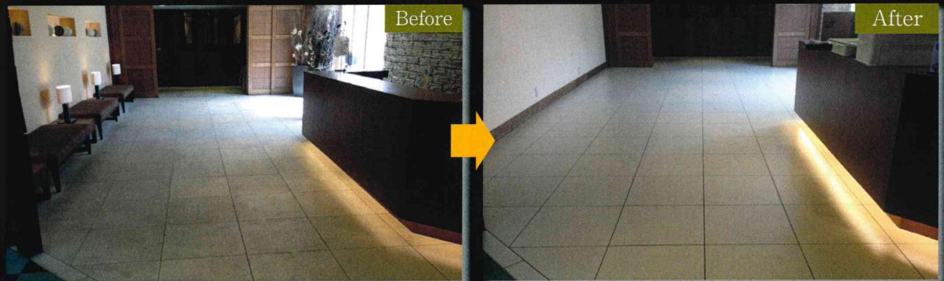
日常的に界面活性剤の入った洗剤を用いて床をメンテナンスしているために、汚れが付着することになり、汚い状態になっていました。完全に汚れを除去して、表面にガラス系のコートで仕上げて汚れない床、メンテナンスが簡単な床が完成です。
