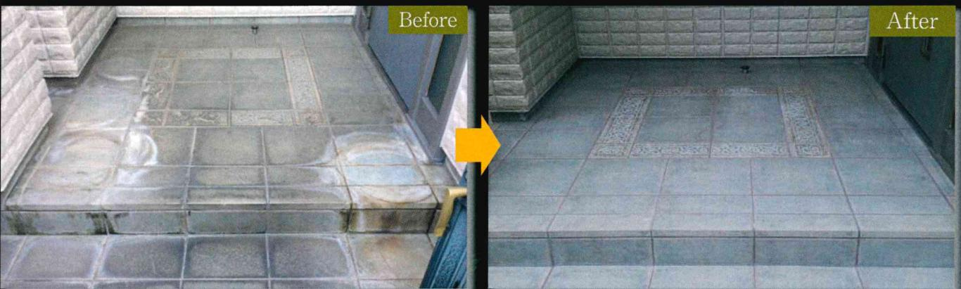
玄関タイルの上に植物の鉢や、金物等を長期間置いておいたことが原因で、汚れやサビが発生している状態です。特殊洗浄などによりシミやカビ、サビを抜いて、全体に塗膜性コーティングを行い目地の防水性能を高め、タイル表面の汚れ防止加工をしています。
