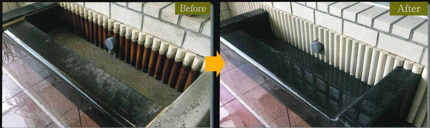
温泉施設のスケールが、壁にしつかりついて汚くなっています。周りの御影にもスケールが付いています。全面リニューアルオープンの工事において、完全にスケールを除去し、新品と同じ状態に再生。
