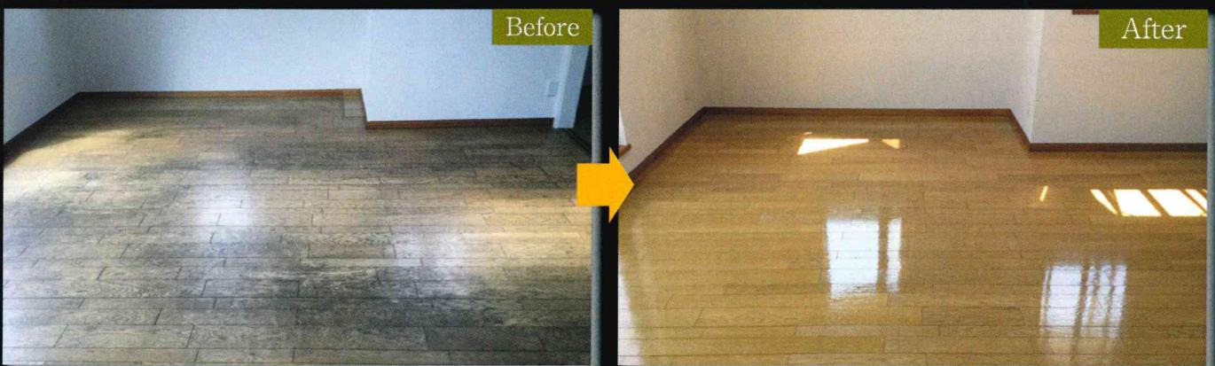
ワックスには汚れを取り込む習性をもっており、油等がワックスの中に入っている状態です。この上から、ワックスをかけても、黒光りするだけで美しくなりません。完全にワックスを取り除き、シミを抜いてキズ補修後、コーティングして汚れない床が完成。
