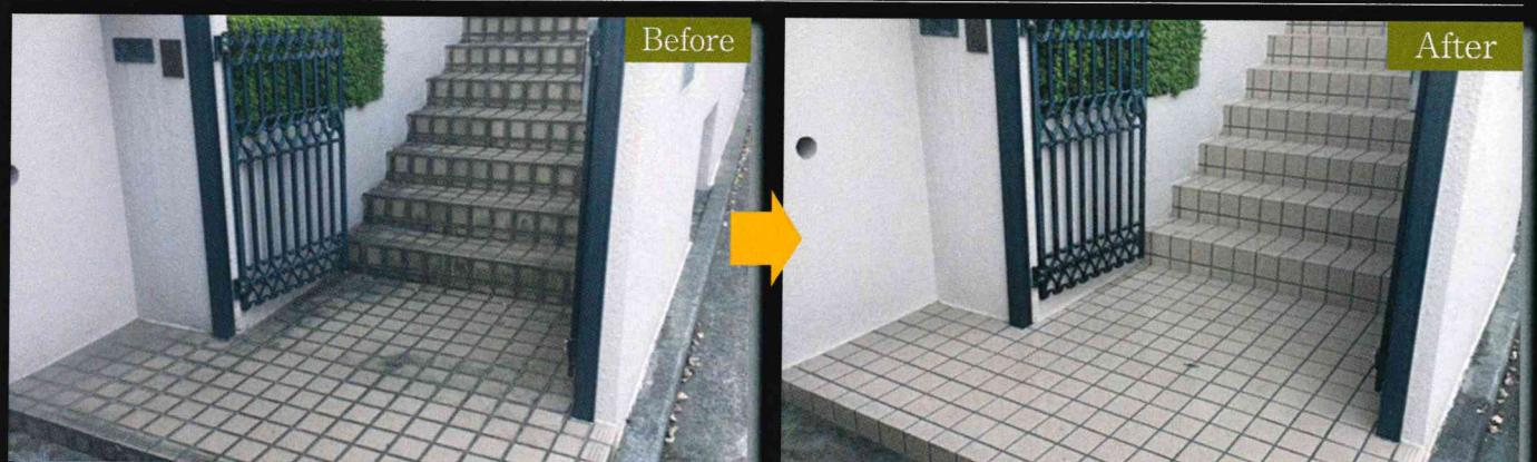
長年の使用と上段から下段への雨水の流れ等により、目地からのエフロ等が発生し、それに水アカや汚れが付着している状態です。洗浄を行うことによりシミやカビ、サビを抜き、コーティングで汚れにくい加工を行なっています。(エフロの処理は別途作業が必要となります。)
