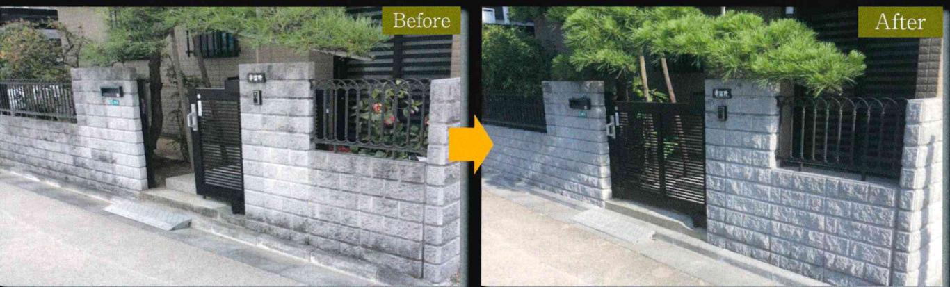
玄関門壁が雨や外部からのほこり、植物からの樹液等により汚れている状態です。汚れやシミ・カビを安全な電解水等を用いて洗浄して除去し、浸透性のコーティングで酸性雨からの劣化や汚れ防止を行なっています。
