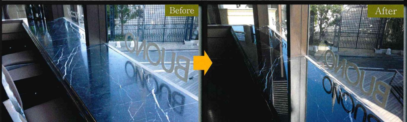
リフォームの時に大理石を取り換えることなく、研磨による磨きを行い、表面にガラスのコーティングで、新品同様の輝きを戻しています。水拭きしても大丈夫な大理石となっています。
