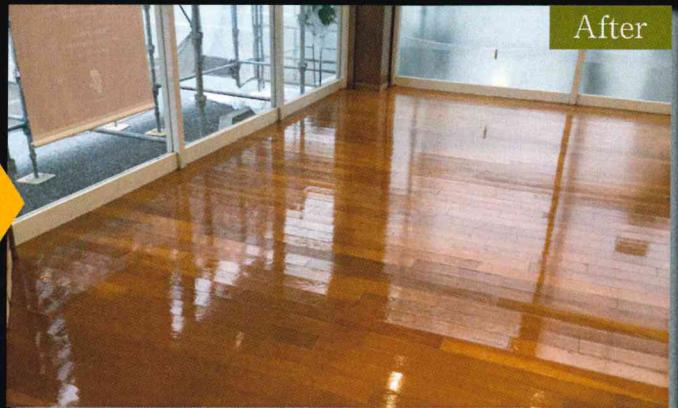
床が油汚れにより、常にベタベタして見苦しい状態です。ワックスを全面剥離し、その後脱脂、シミ、カビ抜きキズ補修をして下地を作りトップコートで仕上げています。
