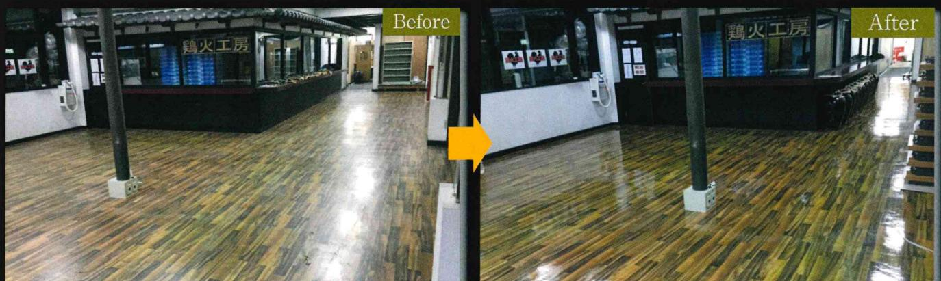
焼き鳥を出すおみやげ屋さんのホールを、全面的に洗浄して油を取り除いた後、コーティングしてノンスリップで汚れない床を完成させています。油が付着しない床になっているため、電解水で簡単にメンテナンスできます。
