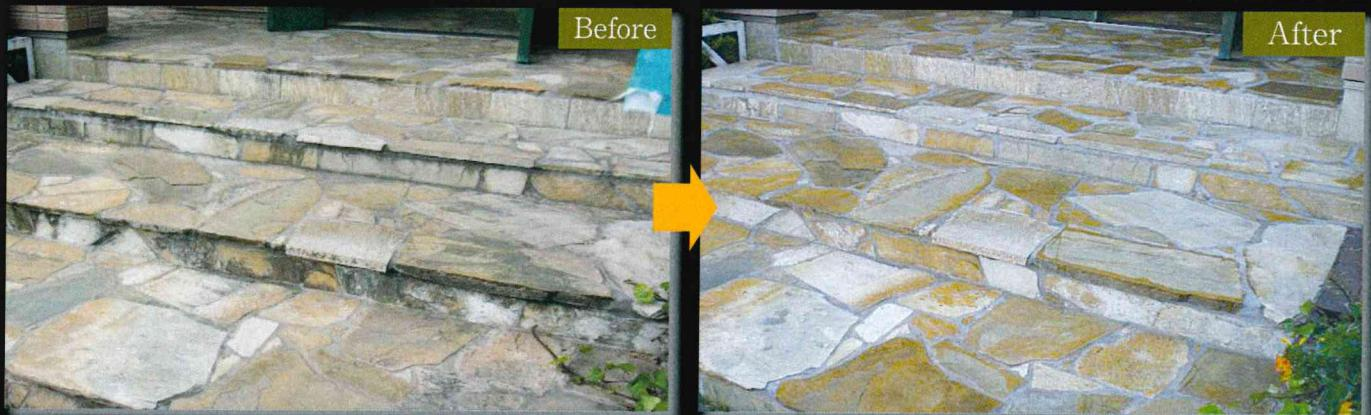
天然石が長年の雨やカビにより汚れている状態です。特殊洗浄等によりシミ・カビ等を取り除き、多穴質系の浸透性コーティングで汚れ防止加工を行いました。天然石は表面の穴の状態により、それに適合したコーティングを提案しています。
