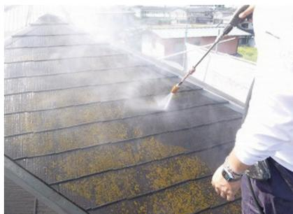
屋根に付着した苔などを高圧水で丁寧に洗浄していきます。
